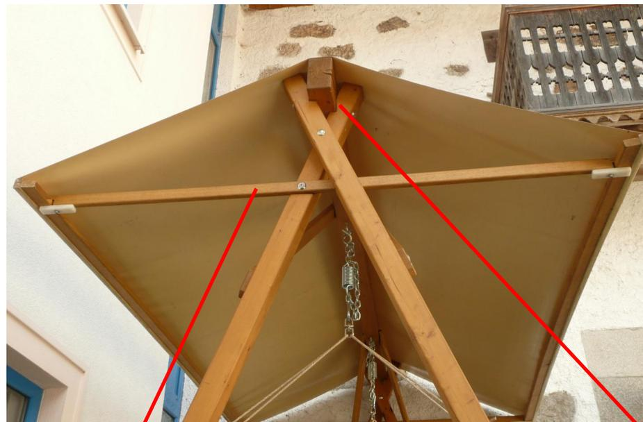
1. Die Querträger wie abgebildet mit 4 kurzen Schrauben anschrauben
